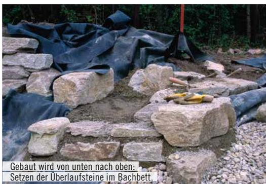
Gebaut wird von unten nach oben: Setzen der Überlaufsteine im Bachbett.
