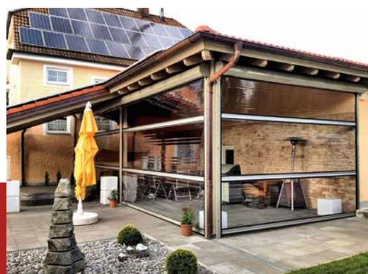
RollFenster lassen sich bei Bedarf elektrisch herunterfahren.
