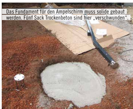
Nach dem Aushärten des Fundaments wird der Sockel montiert.
