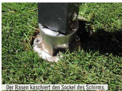
Nach dem Aushärten des Fundaments wird der Sockel montiert.
