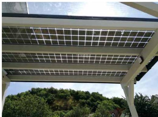
Neu im Sortiment sind Glaselemente für Überdachungen, die Strom erzeugen können und gleichzeitig als Sonnenschutz dienen.
