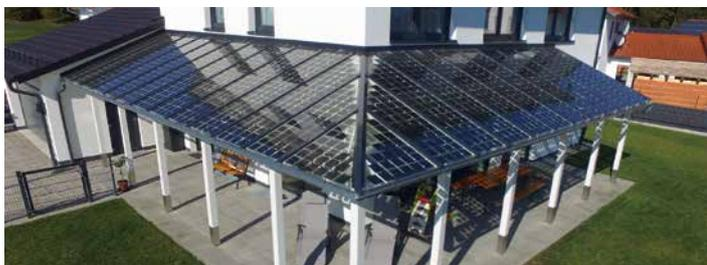
Neu im Sortiment sind Glaselemente für Überdachungen, die Strom erzeugen können und gleichzeitig als Sonnenschutz dienen.
