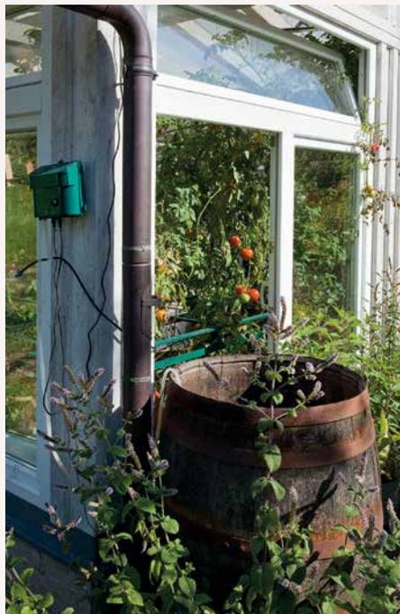
aus. Die Rahmen mit jeweils zwei Fenstern plus Oberlichte wurden als ganze Elemente verwendet, zwei auf der Schmalseite und drei auf der Längsseite. An einer Längsseite ist das mittlere Element durch eine Tür aus dem selben Fundus ersetzt. Um eine vernünftige Höhe bis zum Dachansatz zustandezubringen, wurde die Holzkonstruktion auf eine 40 Zentimeter hohe, fundamentierte Mauer aufgesetzt, ganz nach den Ma-
