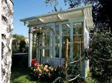
Das kleine Glashaus steht an einer Hecke nahe der Grundgrenze, es öffnet sich zum Garten hin. Die vorhandenen Fenster wurden so eingebaut, dass die Vorderseite höher als die beiden Seitenteile ausfiel. Unter den Fenstern ist die Konstruktion aus senkrechten Stehern an den Ecken und rechts der Türe mit Brettern verschalt, vorne
